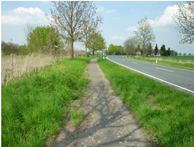
Nord-Süd-Straße zwischen SZ-Bad und Gebhardshagen (B 248)
