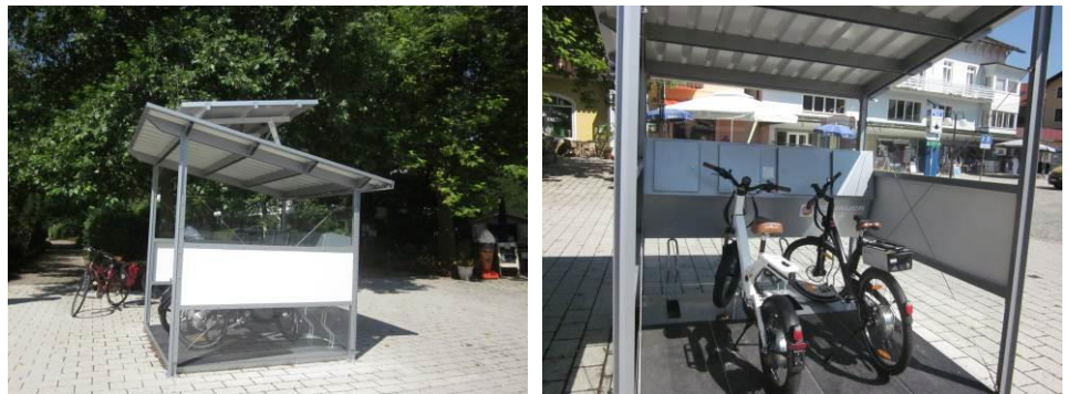
Bild 9- 1: Überdachte Abstellanlage für Pedelecs mit Ladestation (Radfernweg Bodensee-Königssee)
