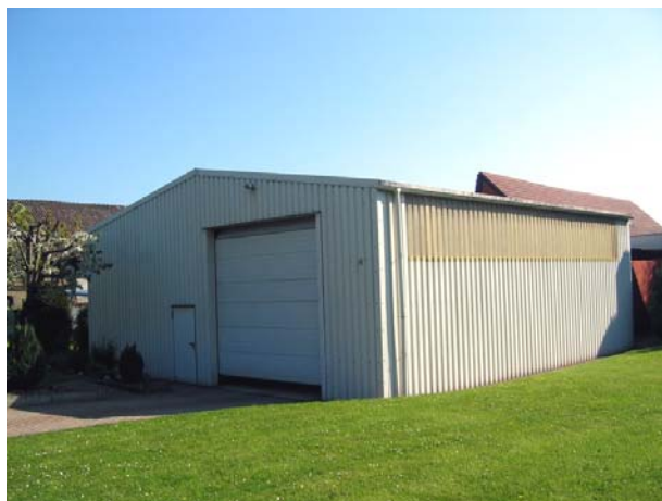
Nutzbares Gewerbeobjekt, Hainholzweg 6
