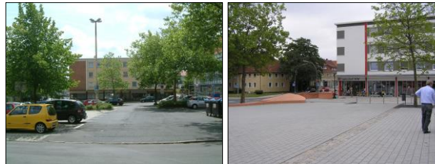
Martin-Luther-Platz vor und nach der Sanierung
