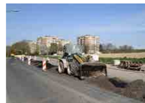
Baumaßnahme Danziger Straße
