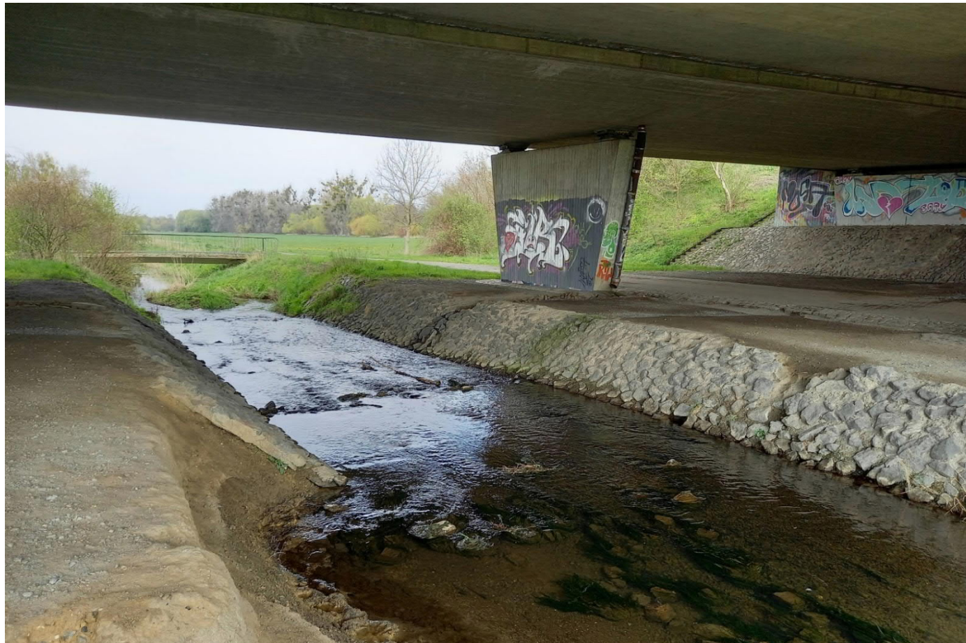
Fuhse unter der Autobahn A39 (gewässerabwärts) (Quelle: agwa 17.4.2023)
