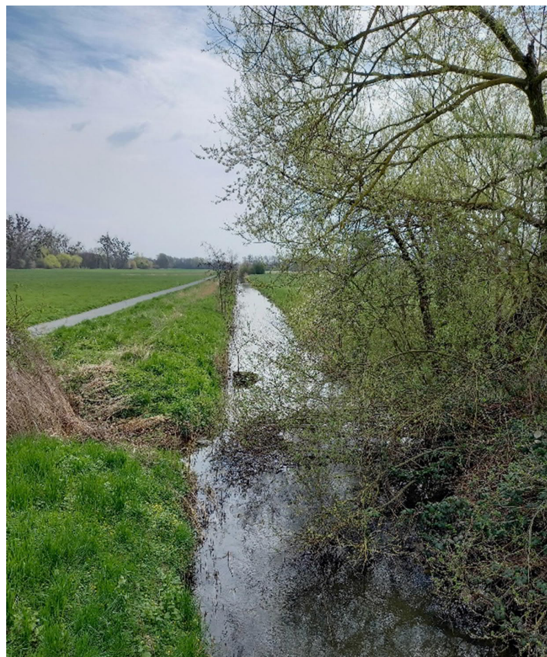
Fuhse Stat. 78+110 (gewässeraufwärts) (Quelle: agwa 17.4.2023)
