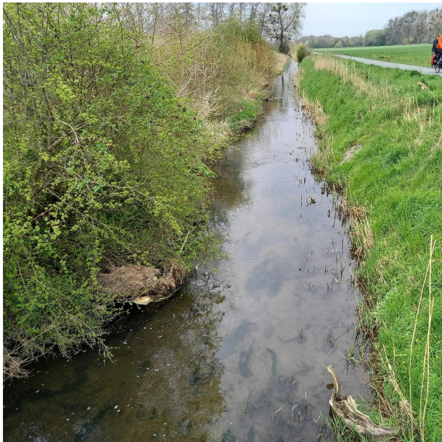
Fuhse Stat. 78+900 (gewässerabwärts) (Quelle: agwa 17.4.2023)
