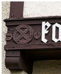
Detail vom südlichen Erker der Schule.
