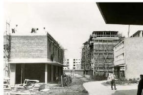
1960: Die Geburtsstunde der Fußgängerzone – Bauarbeiten „In den Blumentritten“.
